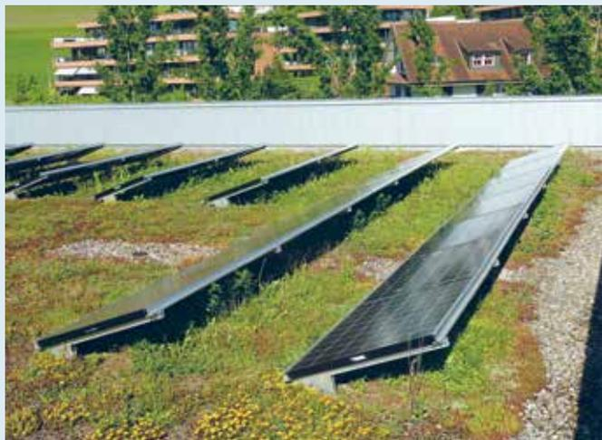
Bild 3: Dieses Befestigungssystem für Solarmodule ist für Gründächer geeignet. Die gesamte Gründachfläche ist gut zugänglich.
