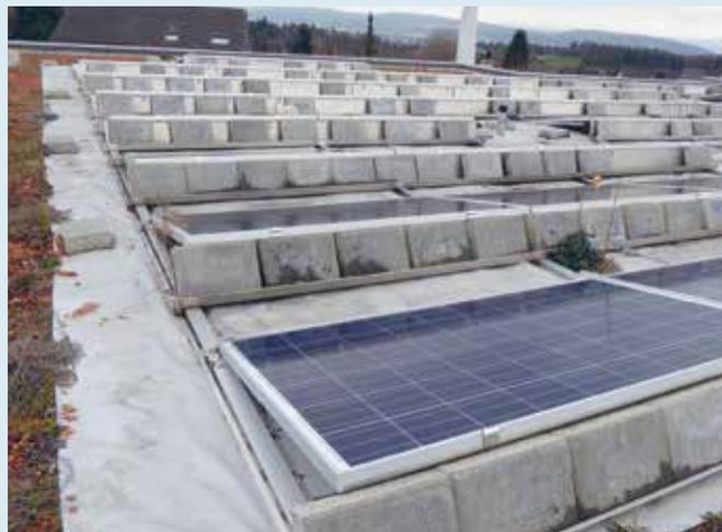
Bild 4: Ungeeignetes Befestigungssystem. Die Fläche unter der Anlage ist nicht zugänglich und wurde deshalb teilweise mit einer Folie abgedeckt. So sieht keine gute Lösung aus.
