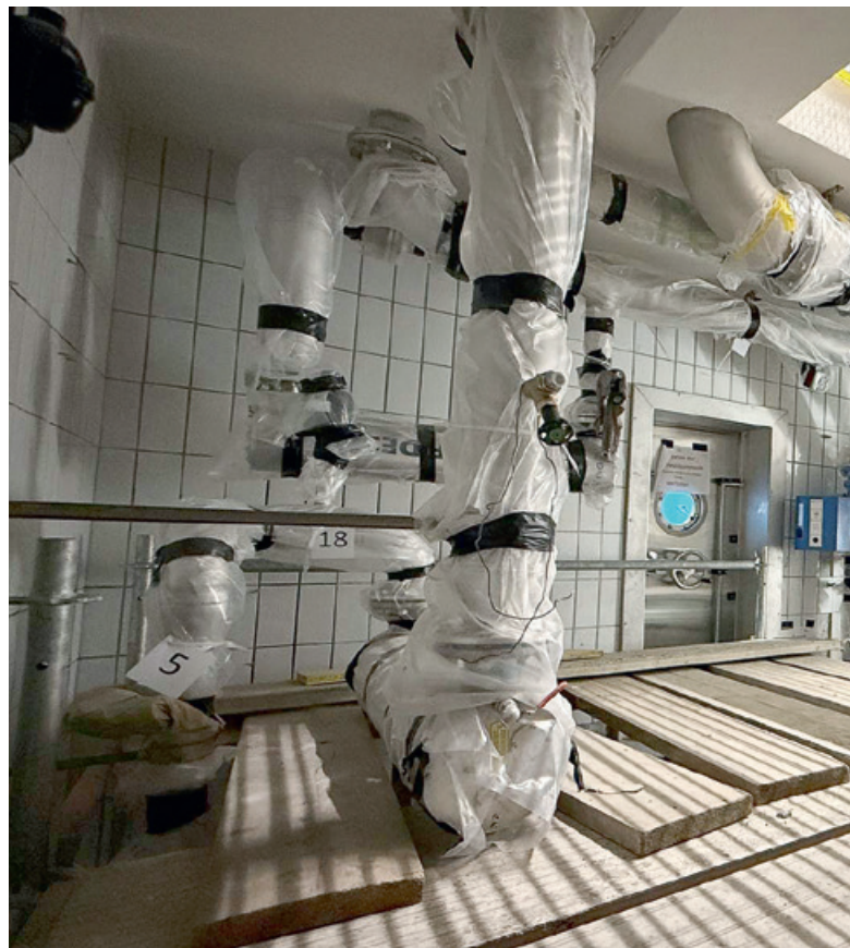
Reservoir Schaanwald, Fertigstellung im Sommer 2025
