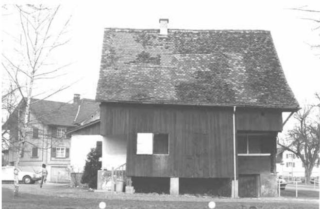
1979 wurde das Wohnhaus unter Denkmalschutz gestellt und 1980 bis 1982 erfolgten eingreifende innere und äussere Erneuerungen. So wurden an den Blockbaufassaden Schindelschirme und an den Fachwerkfassaden ein deckender Putz entfernt. Diverse Balken der Aussenwände wurden ausgewechselt und die Fenster erneuert und geweitet.
