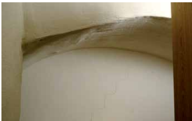
Tonnengewölbe des Kellerraums
