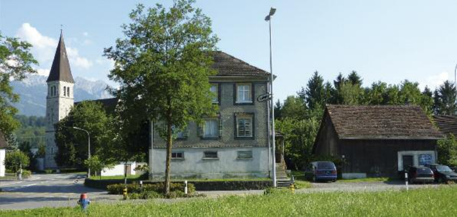
Die Scheune, erbaut 1932, und auch der Anbau von 1949 werden abgerissen. Das alte Pfarrhaus wird damit in seine ursprüngliche Form und Dimension zurückgebracht.
