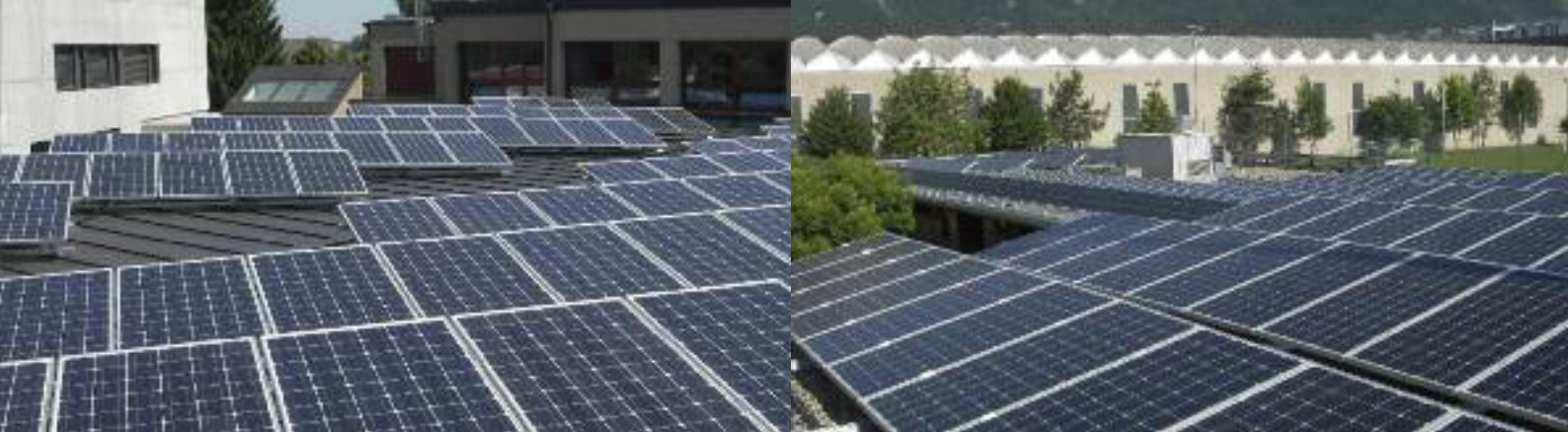
Mehrere Dachflächen von Gemeindebauten werden zur Nutzung von Sonnenenergie mit Sonnenkollektoren bestückt.
