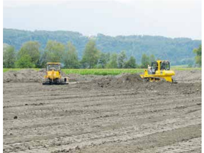
Maschinelle Umsetzung der Rekultivierungsarbeiten – Variante Einbau Erdaushub mittels Raupenbagger.
