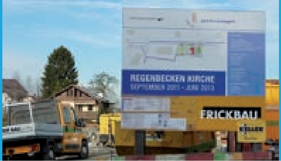
Der Bau des Regenbeckens ist im vollen Gange.
