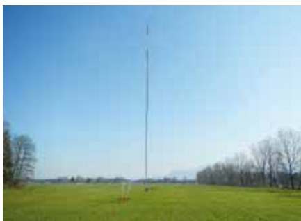
Messmasten der Solargenossenschaft im Ruggeller Riet ausgerüstet mit Windinstrumenten auf 10, 30 und 50 Metern Höhe. Die Anlage wird mit Solarenergie versorgt.
