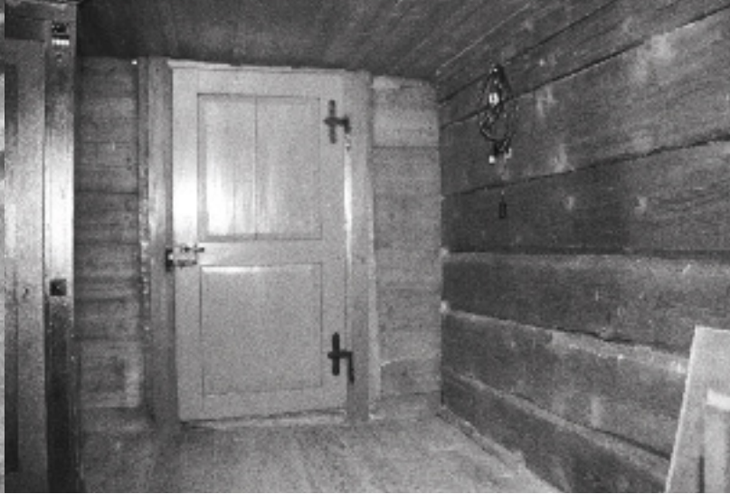
Kellerluzide spätmittelalterlicher/frühneuzeitlicher Art; Sturzbrett um 1792 d. (links)
